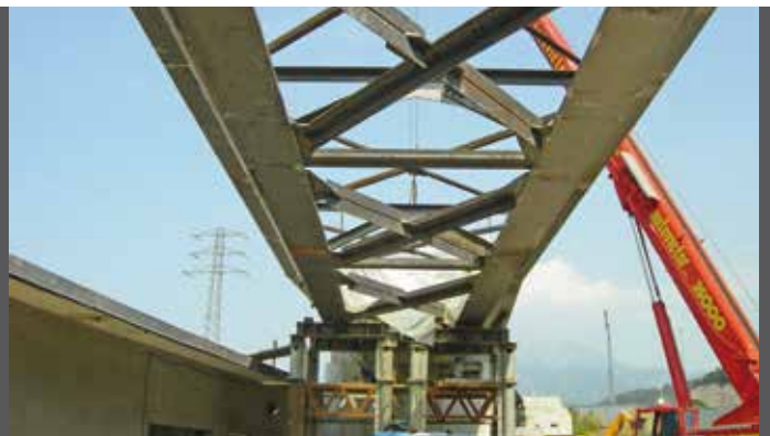
7. L'impalcato metallico del viadotto Nord in fase di costruzione
