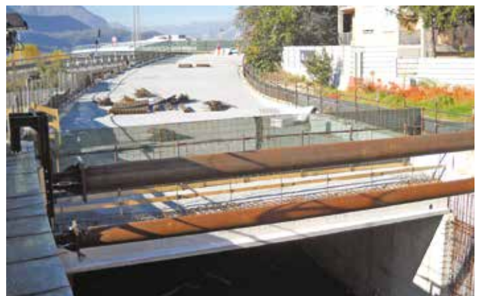
4. La copertura della galleria artificiale Nord
