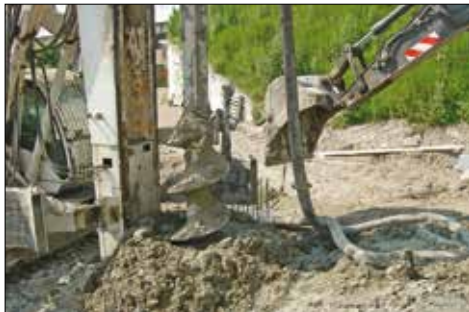
17. L'esecuzione dei pali in cfa al viadotto Nord
