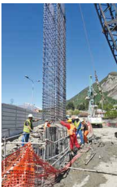
10. Dal cantiere dell'imbocco Sud, la fase di costruzione dei diaframmi
