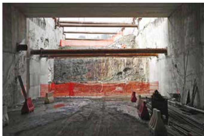
12. L'avanzamento delle fasi di scavo all'imbocco Sud
