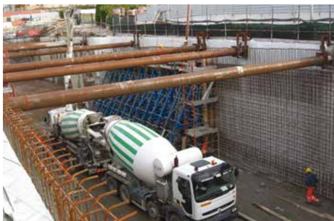
11. La costruzione delle pareti alla galleria artificiale Sud
