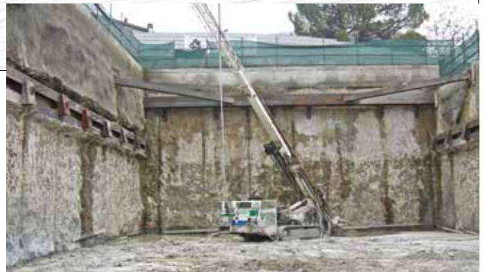
3. Lo scavo della galleria artificiale Nord
