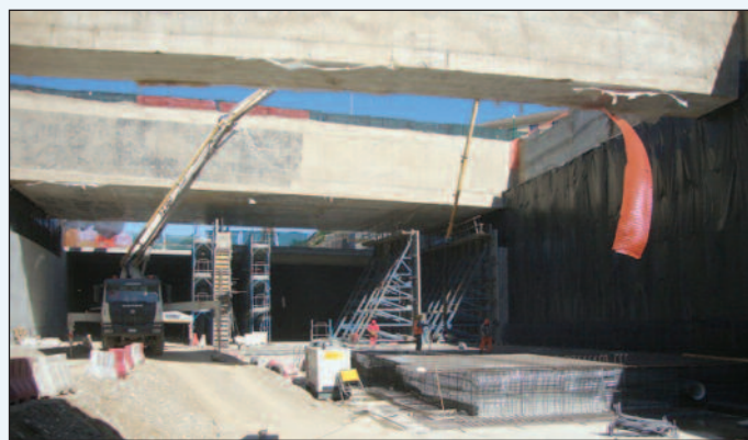
5. La galleria artificiale è stata realizzata in gran parte con il metodo costruttivo dello scavo a cielo aperto tra paratie in c.a., a esclusione di alcune zone ove si è proceduto allo scavo con il "metodo Milano"
