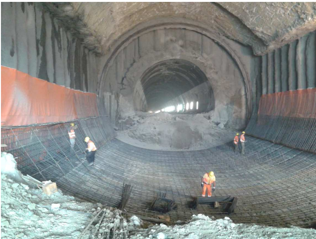
Foto 4- Fase di armatura arco rovescio con vista fronte consolidato
