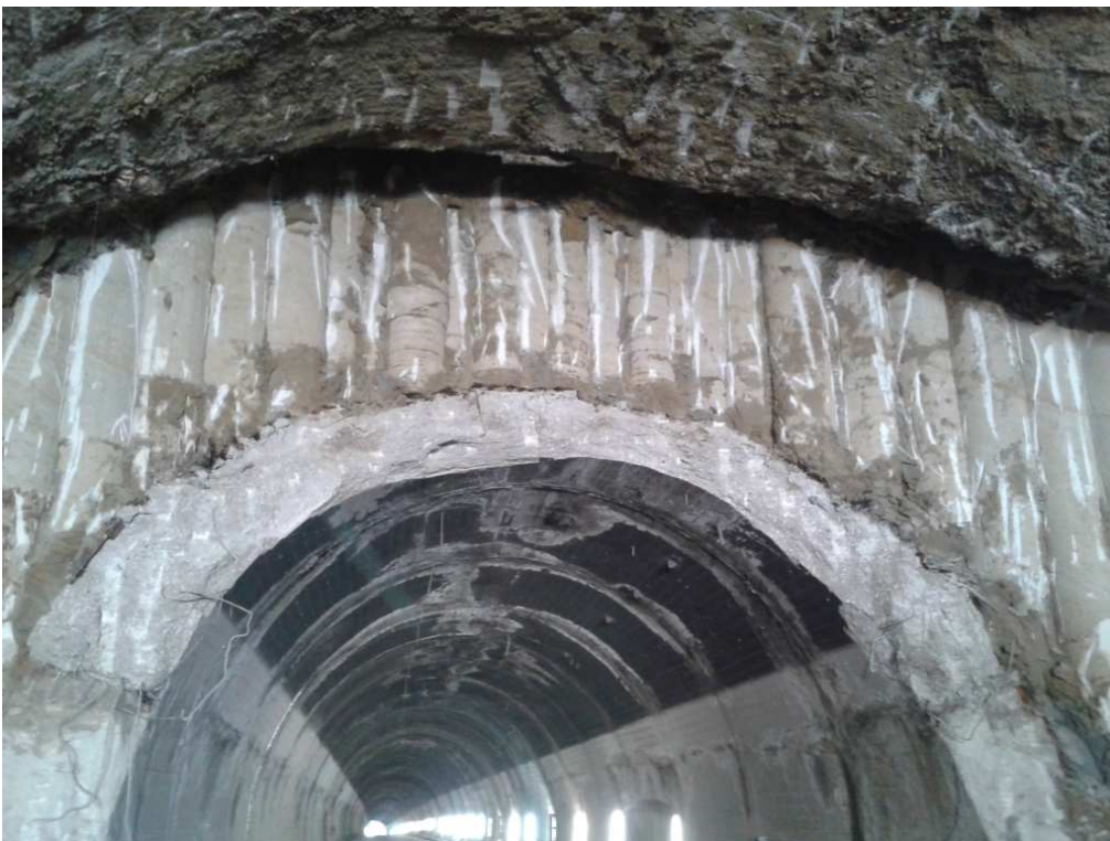
Foto 2- Vista consolidamento con pali CSP
