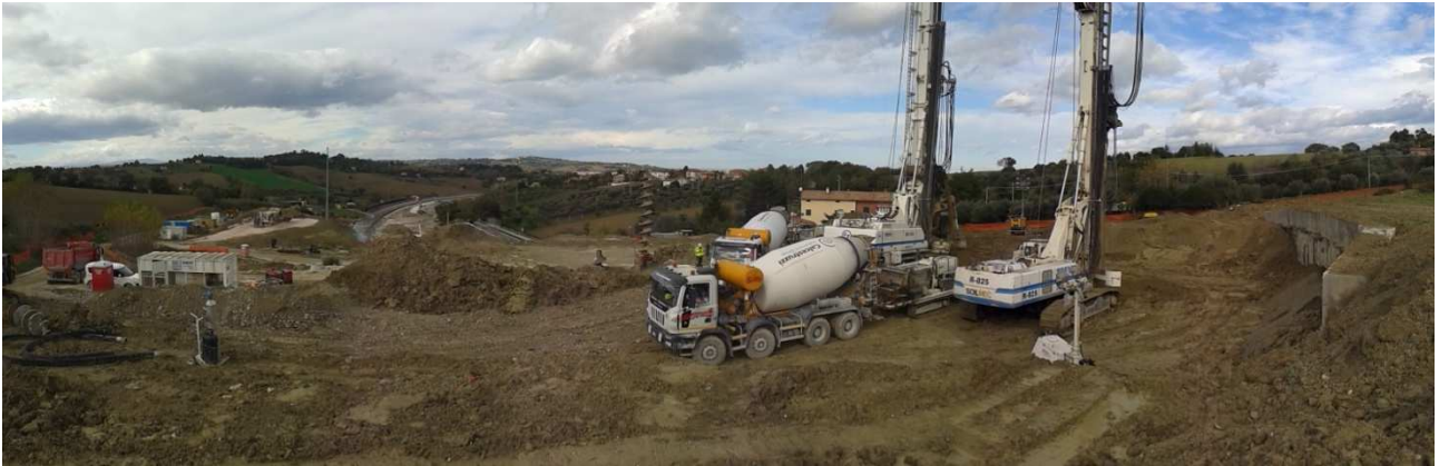
Foto 1- Fase di perforazione e getto
