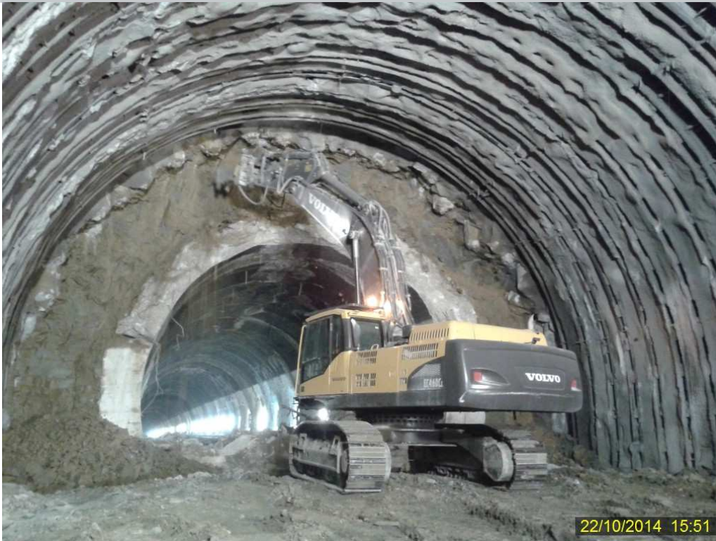
Foto 3- Fase di scavo con demolizione pali e rivestimento galleria esistente
